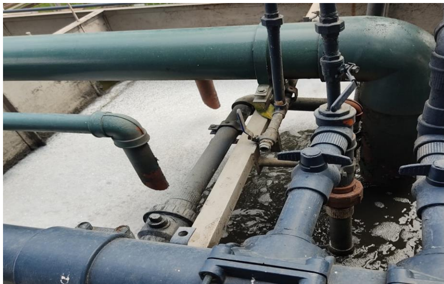
Figura 23. Sistema de aireación biodegrado de las aguas residuales.
