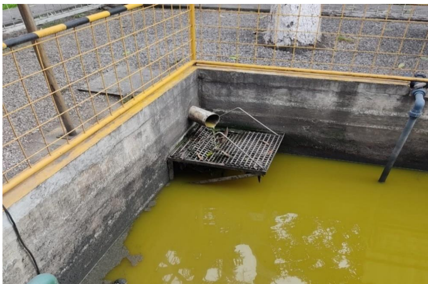
Figura 18. Laguna de estabilización de desechos
