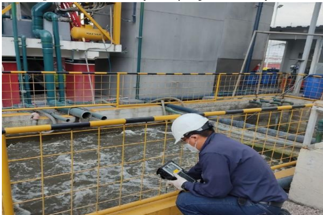
Figura 41. Análisis de Temperatura y oxígeno disuelto en piscina.
