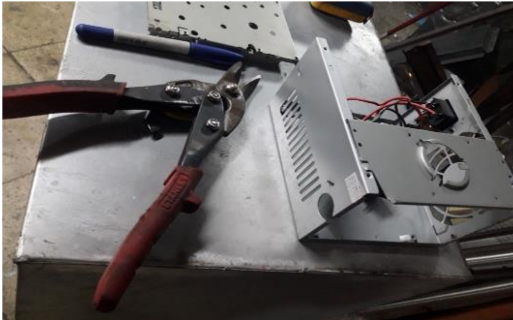
Figura 35. Acoplamiento de las Partes Metálicas de la Estructura.
