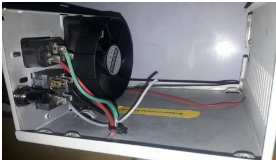
Figura 41. Soldadura de Conexiones en Interruptores y Protecciones.
