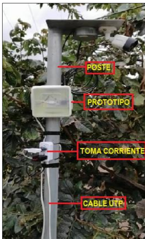
Figura 45 Instalación del nodo final.
