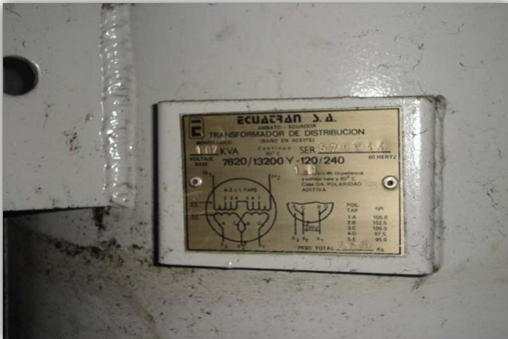
Las conexiones del transformador del lado de baja tensión 120/240 V. Se encuentra con platinas de cobre de 100X10mm con terminales tripes para conductor 500 MCM.
