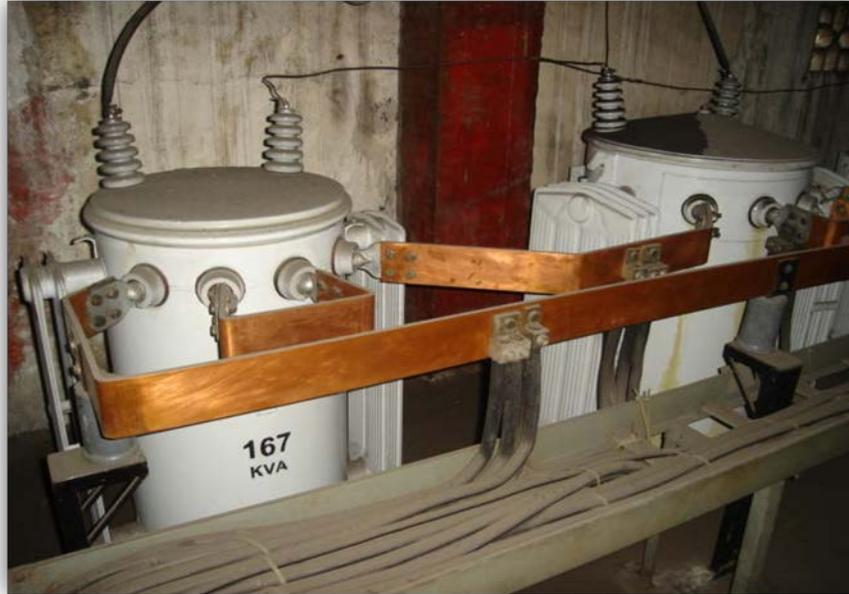
Las conexiones del lado de media tensión del transformador están protegidos con tira fusibles de 40 Amperios, estas son conectadas hasta la celda de media tensión a través de bandejas porta cable.
