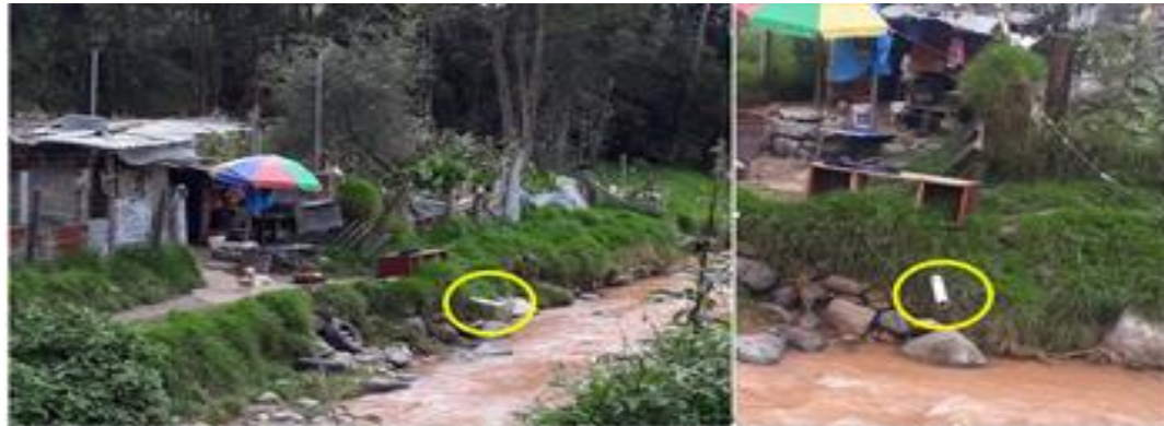
Ilustración 48: Descargas hacia el río Sinincay en el sector “Camino a Patamarca”
