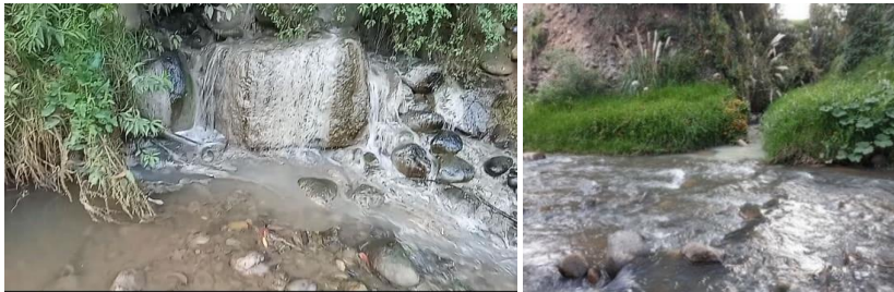
B. Alcantarillados presentes en el sector
