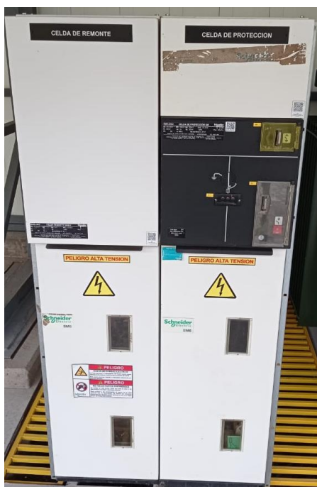
Figura 17. Celda de protección QM SM6-24kV
