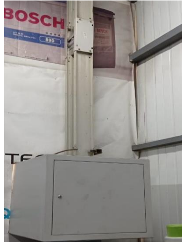
Figura 20. Conexión de Ducto Barra.
