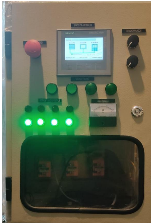
Figura # 38 Estado de salidas mediante MQTT.
