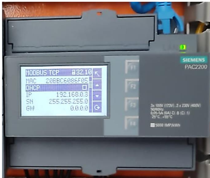
Figura # 208 Configurar IP en Sentron PAC 2200.
