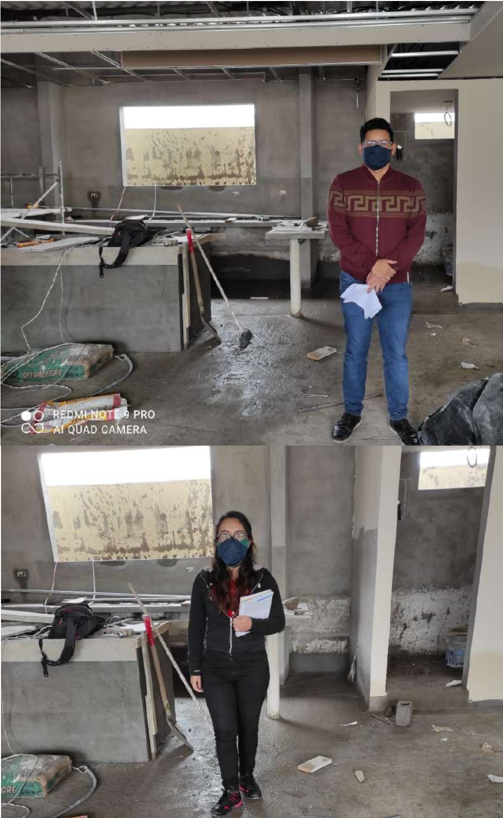
a) Estado de la obra al iniciar.
