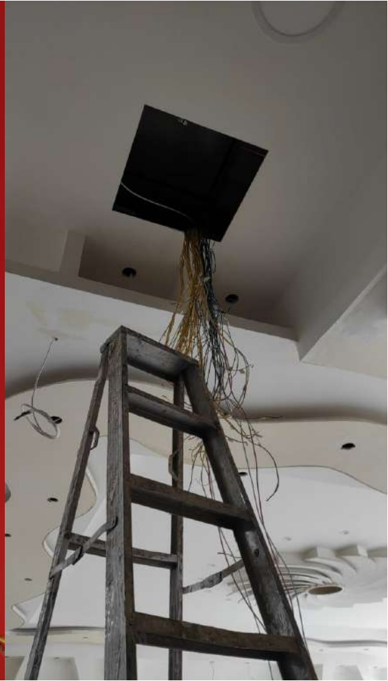
e) Identificación y etiquetado de cables.
