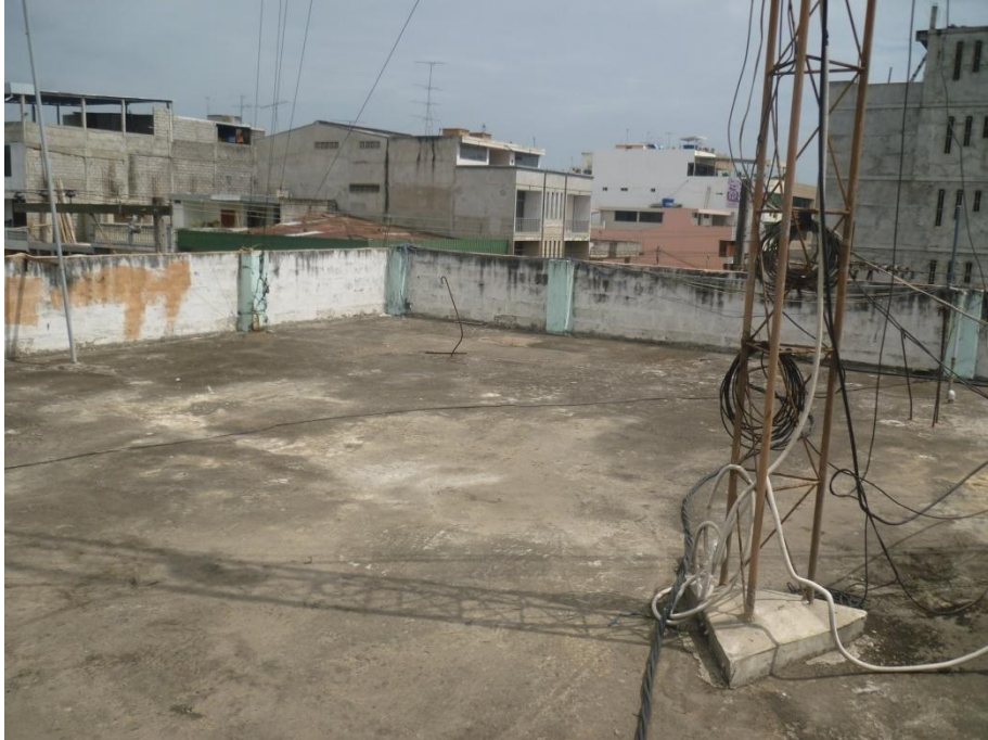
Anexo F.4 Espacio 2 Azotea CNEL El Oro
