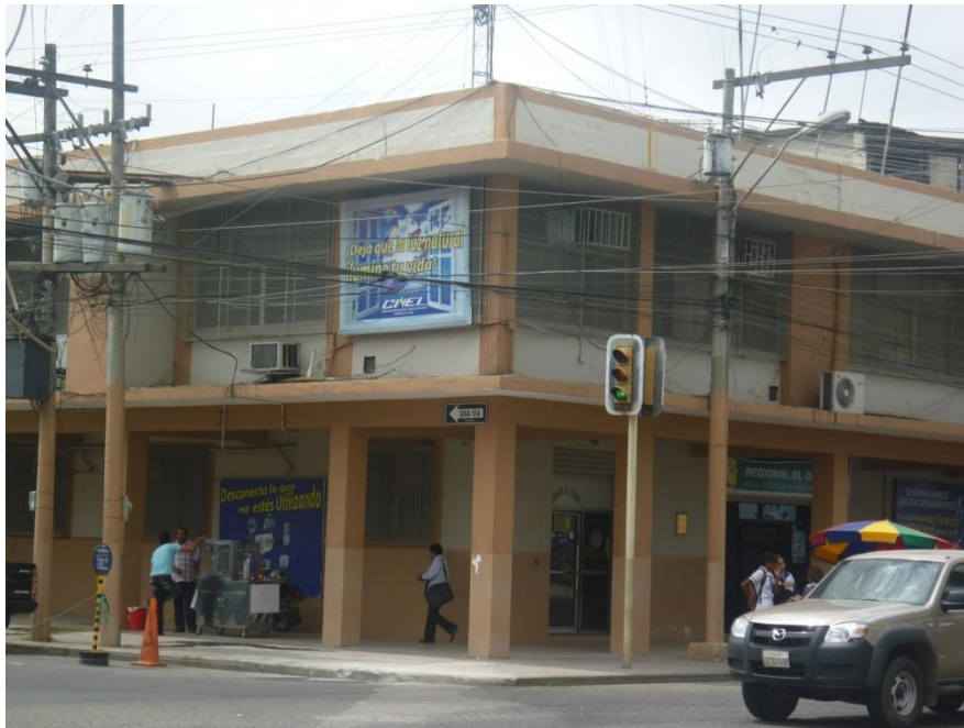
Anexo F.1 Edificio CNEL El Oro
