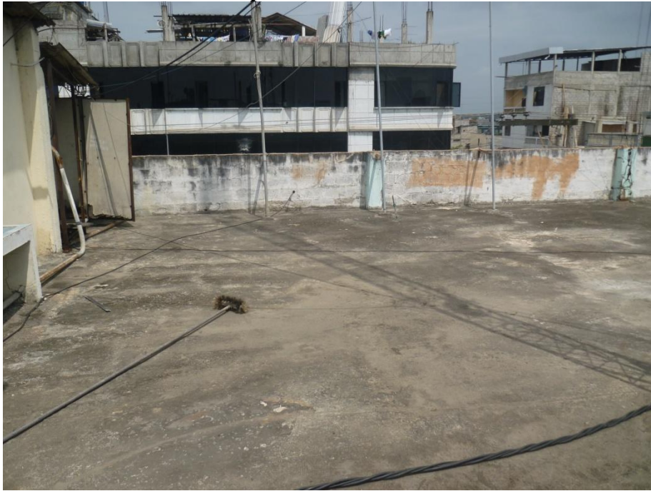
Anexo F.3 Espacio 1 Azotea CNEL El Oro
