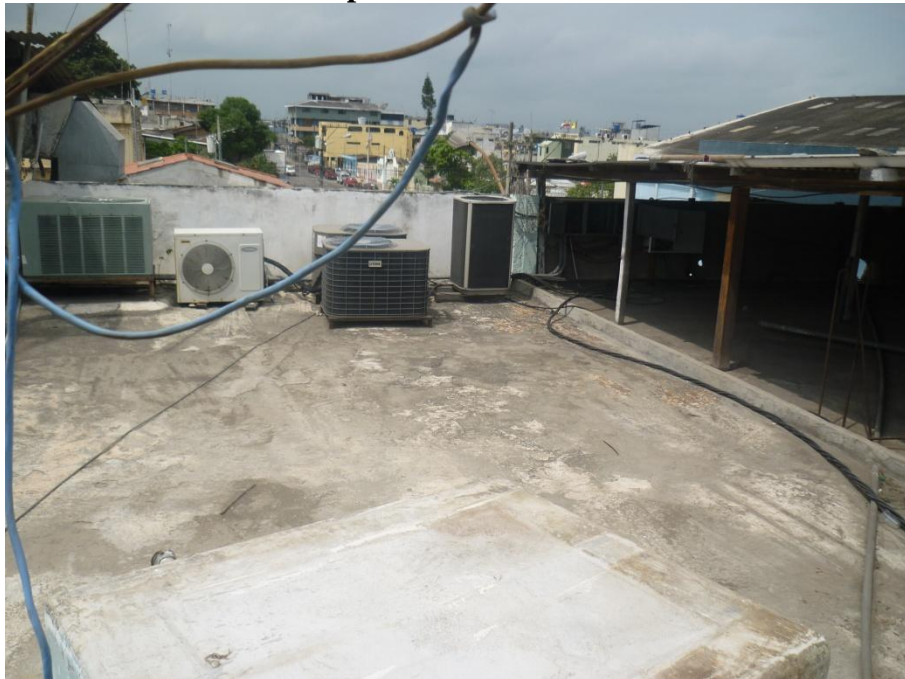
Anexo F.6 Espacio 4 Azotea CNEL El Oro
