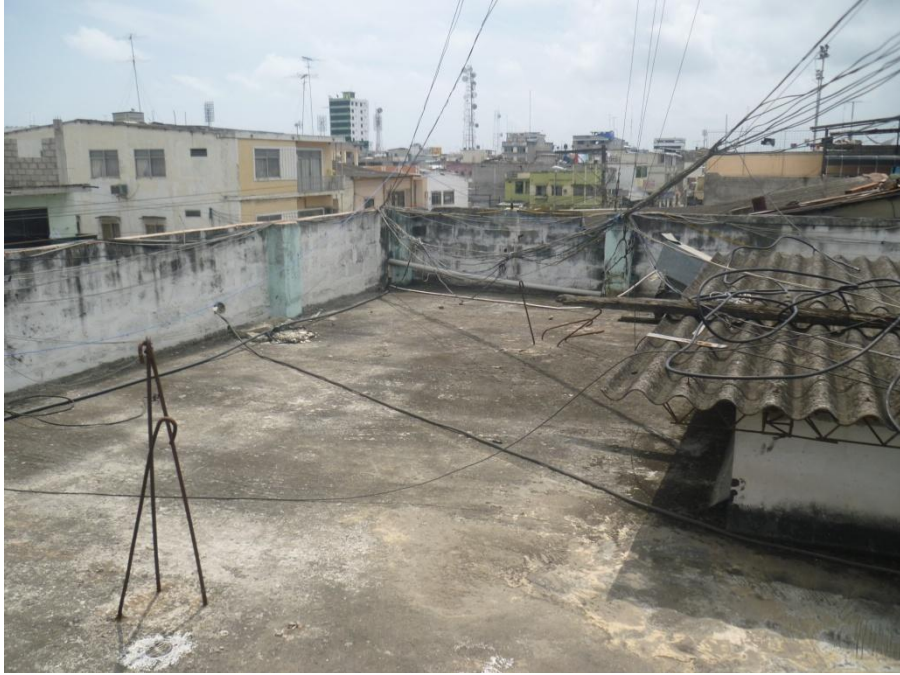
Anexo F.5 Espacio 3 Azotea CNEL El Oro
