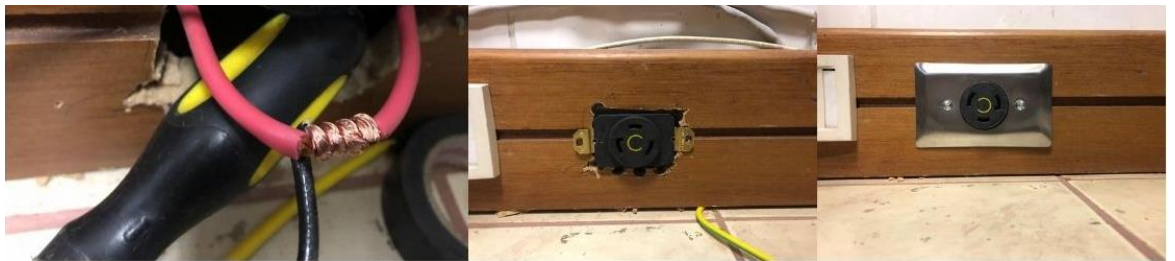
Figura 18 Instalación de Tomacorriente.
