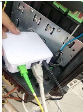
Figura 106 Conexión en la NAP con la ONT.
