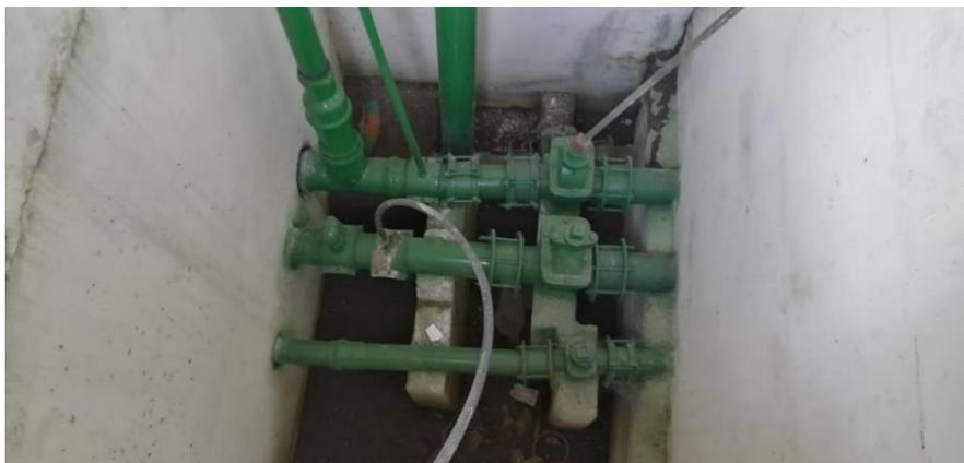
*Nota.* Conexiones de salida para la distribución de agua potable. Elaborado por: El autor.
