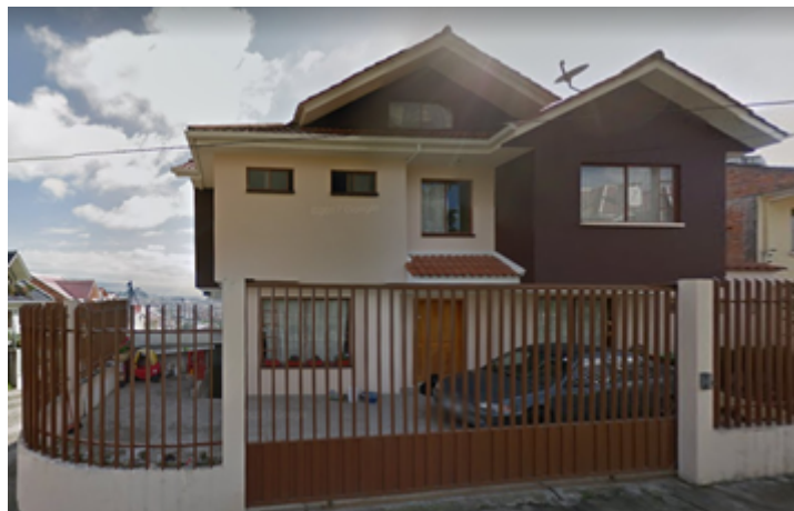
Figura 3.1: Vista frontal de la vivienda.
