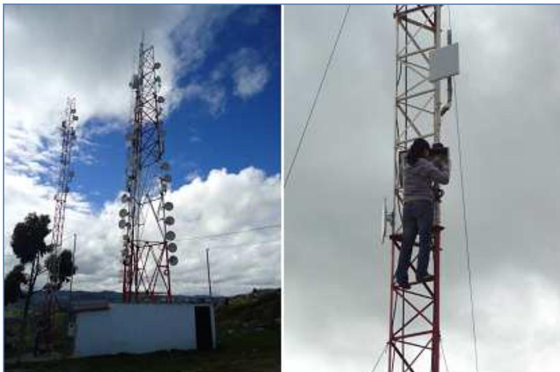
La alineación de las antenas se realizó con ayuda de los indicadores de las antenas ya que grafican la calidad con la que la señal está siendo transmitida.
