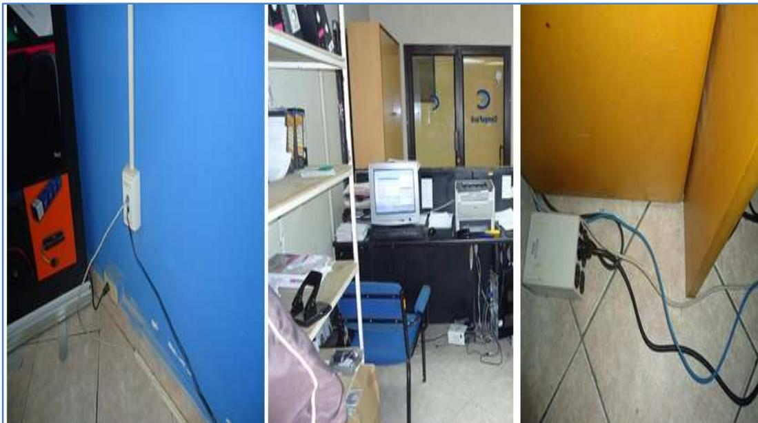
Figura 2.1: Fallas de Cableado
