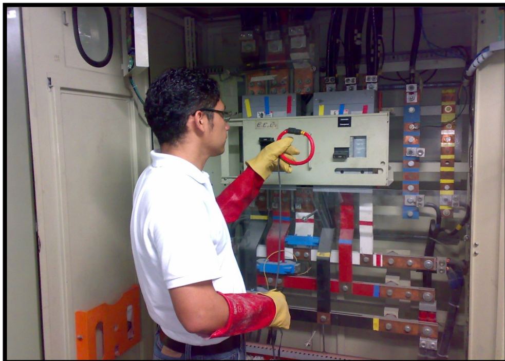
Ilustración 58: Instalación de ganchos para medición de corriente, en la foto Fernando Proaño. Fuente: Autor
