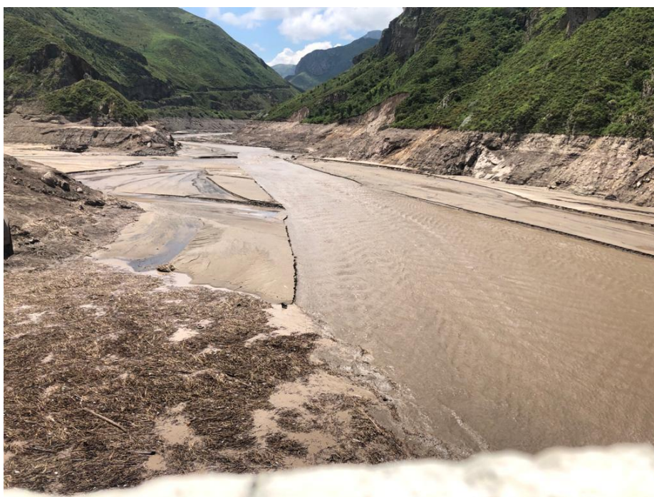
Ilustración 4: Acumulación de madera al evacuar el agua del embalse.
