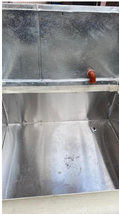
Figura 28: Válvula de ingreso de agua
