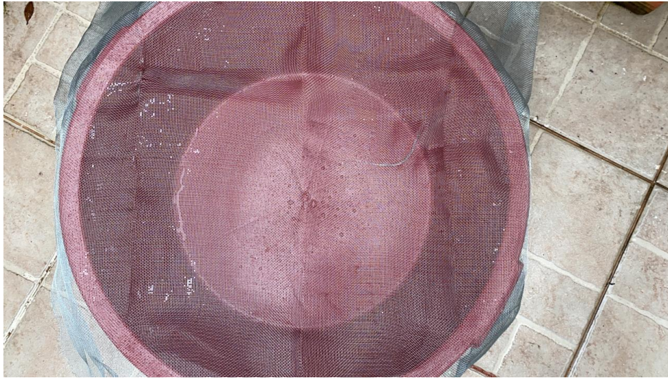
Figura 19: Tanque recolector de agua lluvia
