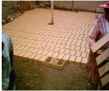
*Figura 3. Moldeo de ladrillos. Fuente: [2]*
