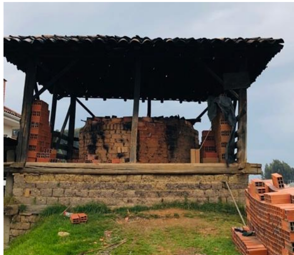
Figura 36. Horno cilíndrico de cocción de ladrillos. Fuente: Autor.
