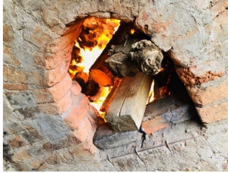
Figura 42.- Alimentación de la cámara de combustión. Fuente: Autor.
