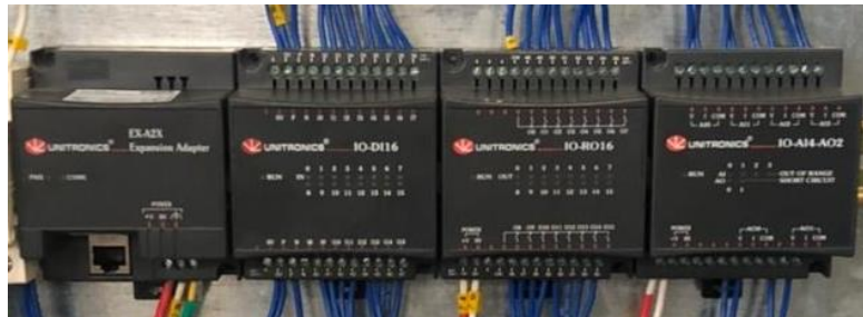
Fig. 56 Adaptador y módulos de expansión colocados en el panel eléctrico.
