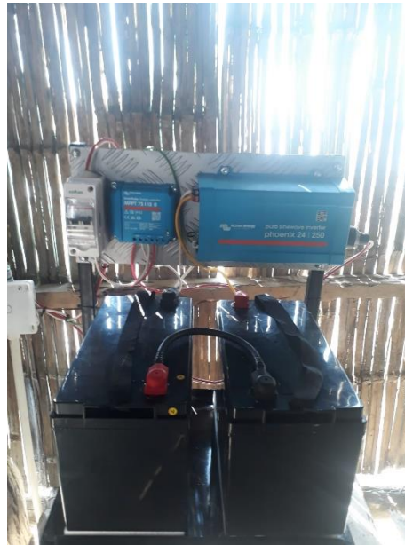
Figura 63.- Instalacion de los elementos fotovoltaicos Fuente: Autores
