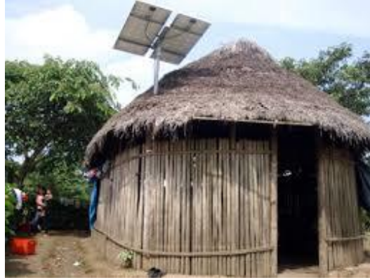
Figura 6.- Aplicación de sistema Fotovoltaico en zonas rurales Ecuador. Fuente: Sopelia
