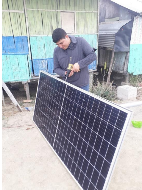
Figura 60.- Colocacion del panel en la base metalica Fuente: Autores
