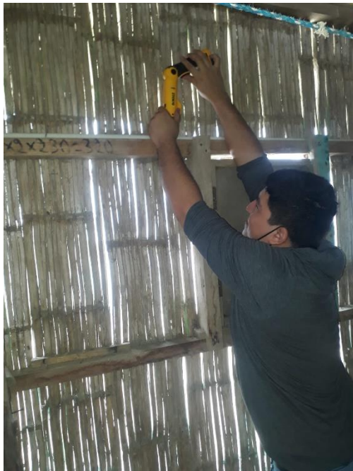
Figura 53.- Colocacion de tubo PVC Fuente: Autores
