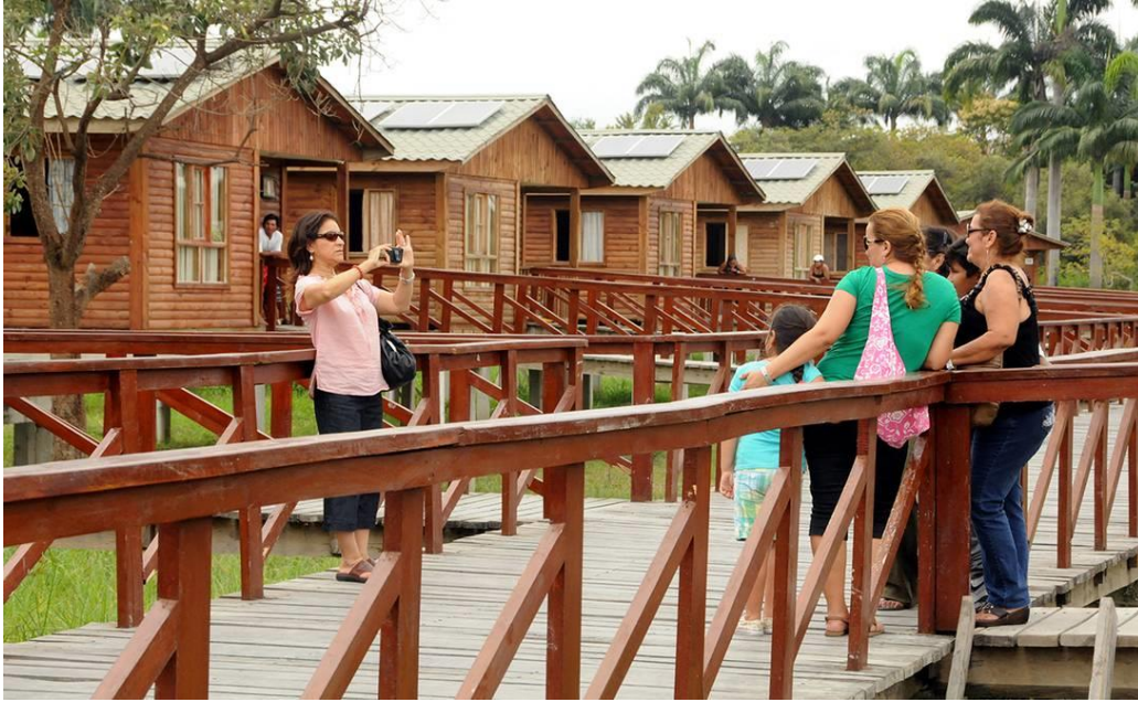
Figura 7.- Paneles solares proveen luz en la isla Santay Fuente: El Universo
