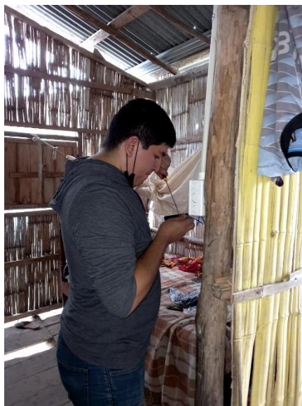
Figura 55.- Conexion de interruptor Fuente: Autores
