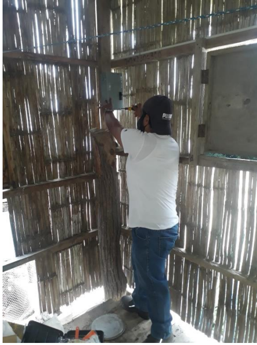
Figura 52.- Instalacion panel de distribucion Fuente: Autores
