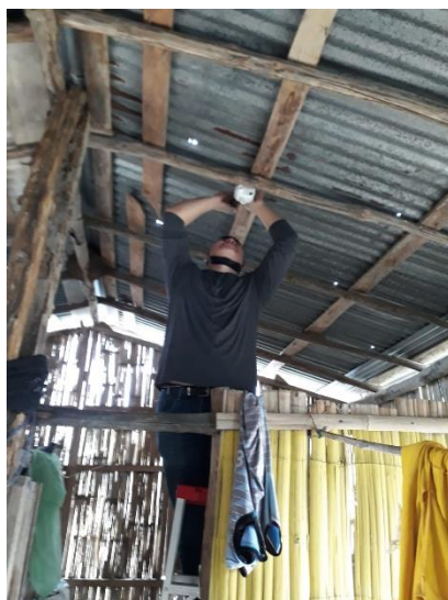
Figura 56.- Conexion de la boquilla Fuente: Autores
