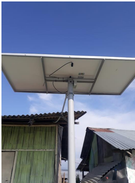
Figura 64.- Vista final del proyecto Fuente: Autores
