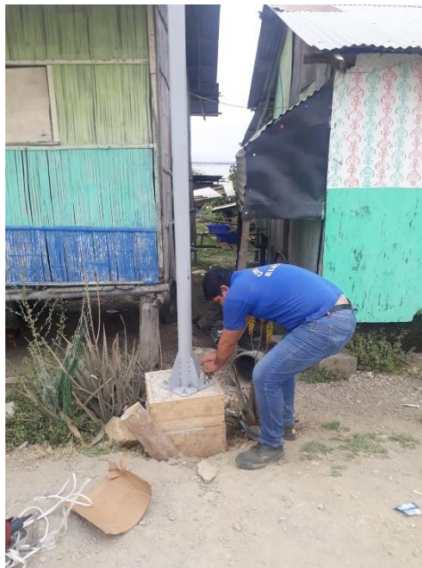
Figura 59.- Colocacion del tubo metalico Fuente: Autores
