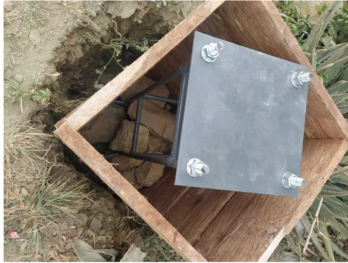
Figura 58.- Elaboracion de la base de concreto Fuente: Autores
