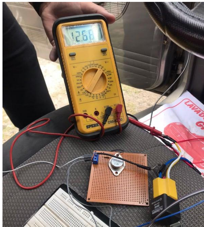
Figura 4.13 Activación de la bomba de combustible Fuente: Autores.
