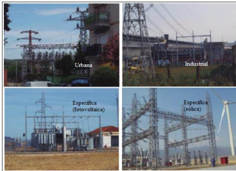
Figura 1.9. Subestaciones eléctricas según la ubicación
