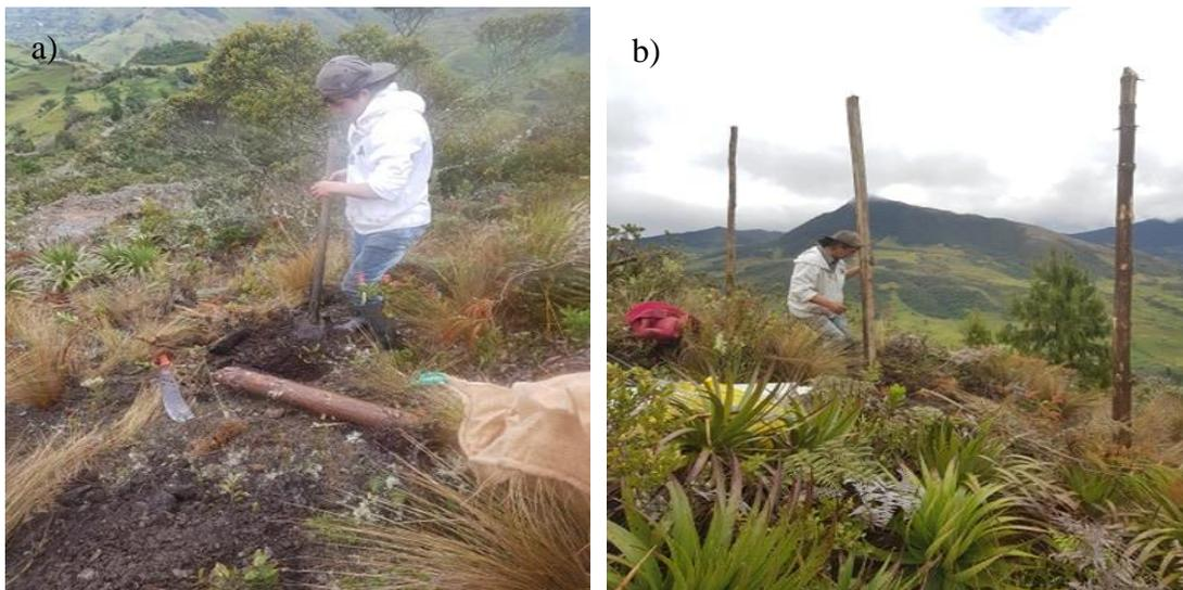
Ilustración 17: a) Excavación de agujeros, b). Fijación de los postes de madera a una distancia de 1.6 m entre ellas. Fuente: Autor (2021).
