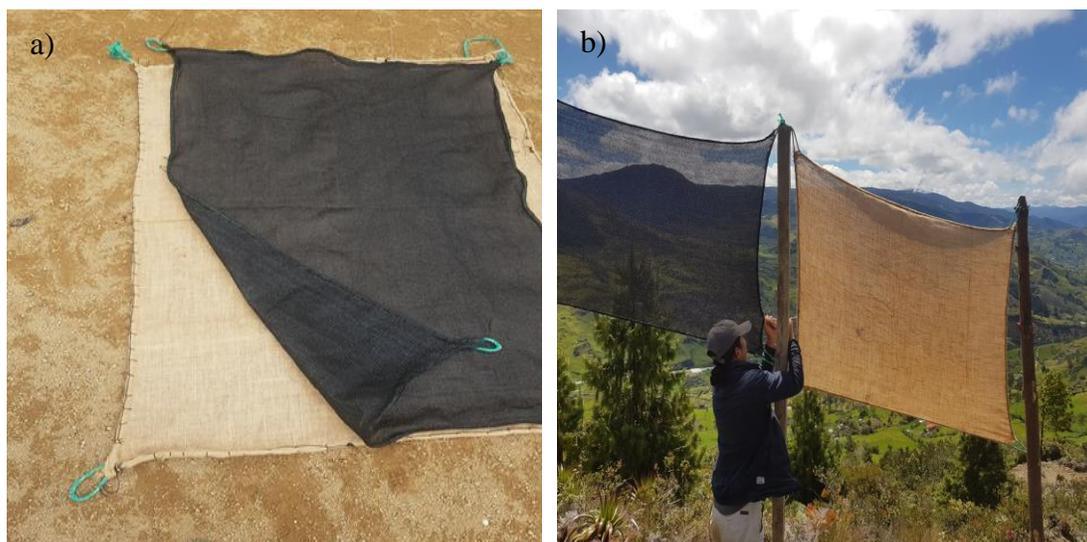
Ilustración 18: a) Acople de cuerdas en los elementos captadores. b) Montaje sobre los soportes previamente fijados en la superficie. Fuente: Autor (2021).
