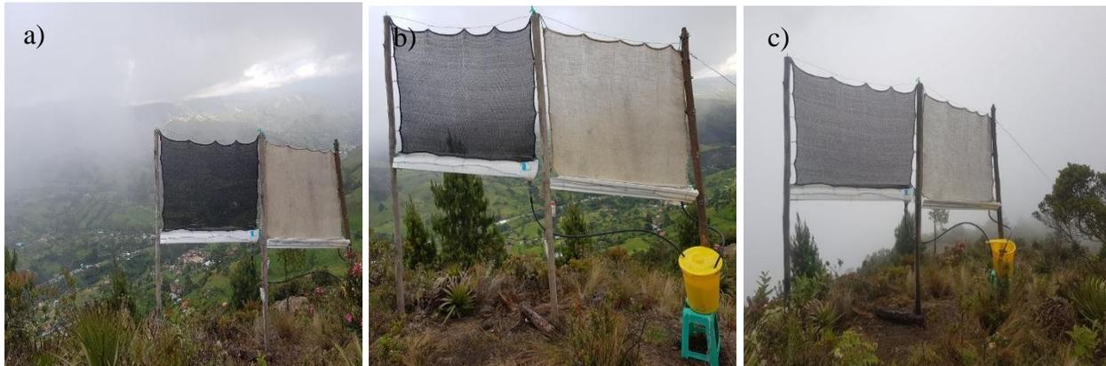
*Ilustración 21: a) montaje de las canaletas de recolección, b) conexión de sistema de almacenamiento con las canaletas de recolección, c) ajuste del tensor de la infraestructura con la superficie de la tierra. Fuente: Autor (2021).*
