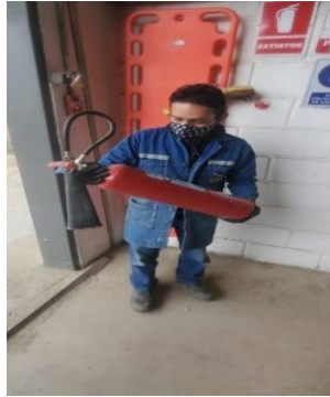
Ilustración 47 Revisión de manómetros de extintores de I.G.M. Fuente: Autores
