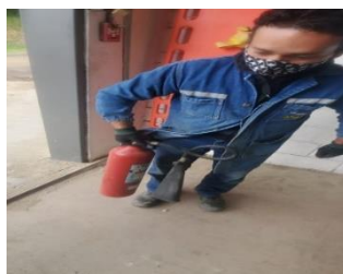
Ilustración 46 Revisión de peso de extintores en I.G.M. Fuente: Autores
