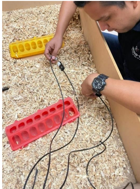
Figura 4.1 Montaje de sensores de temperatura y humedad relativa
