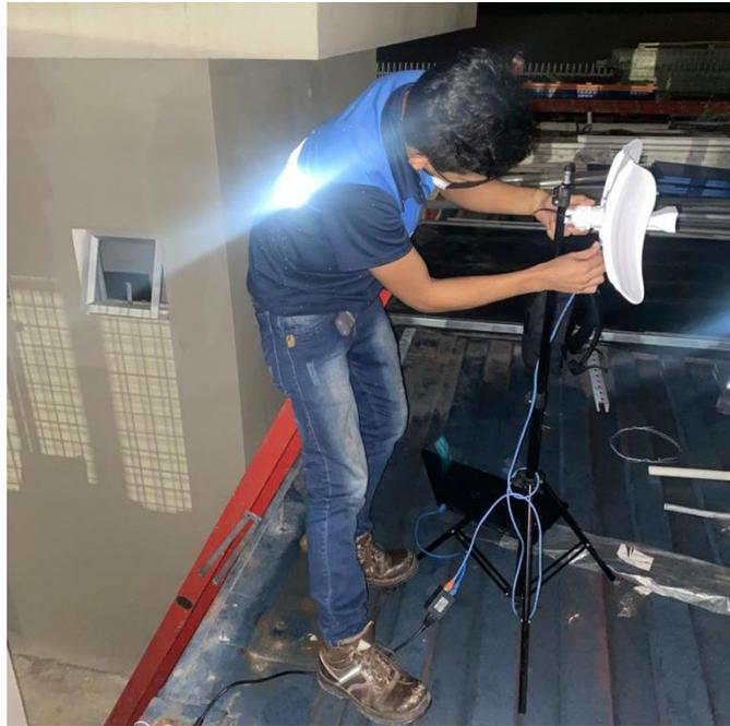
**Figura 7: Instalación de equipos en estación Durán.**
