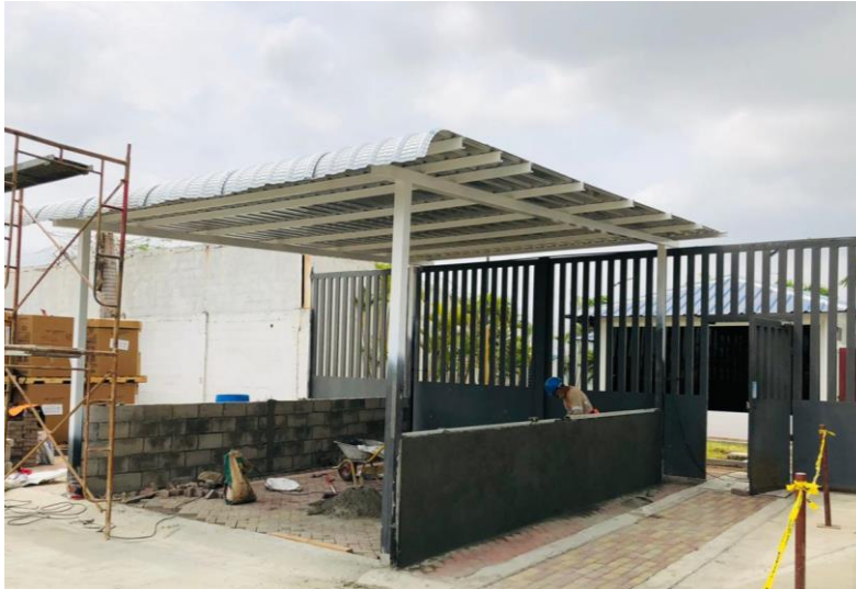
Figura 9. Estructura previa a la finalización de la construcción de la bodega
