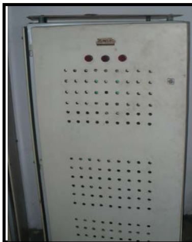
Fuente: Los Autores, Ilustración 20, Tablero de Cargas Esenciales TDP3, 2010.
