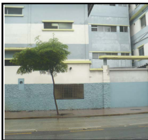
Fuente: Los Autores, Ilustración 14, Ingreso de acometida subterránea del Hospital León Becerra, 2010.
