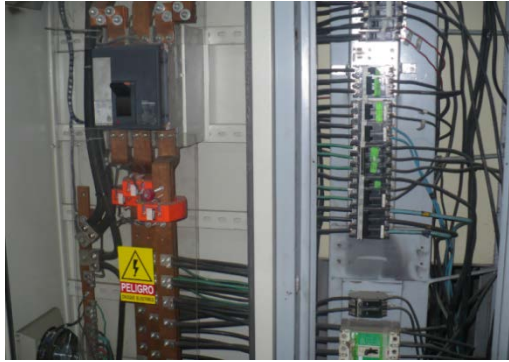
Fuente: Los Autores, Ilustración 29, Tablero TDP1 con sus Breakers, 2010.
