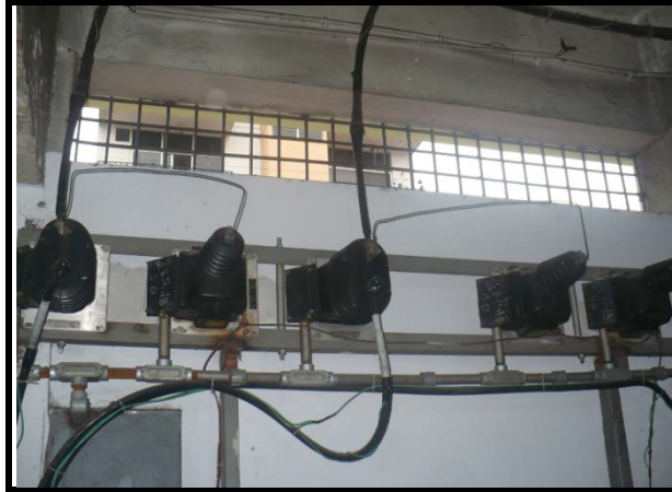
Fuente: Los Autores, Ilustración 17, Transformadores de Potencial y de Corriente, 2010.
