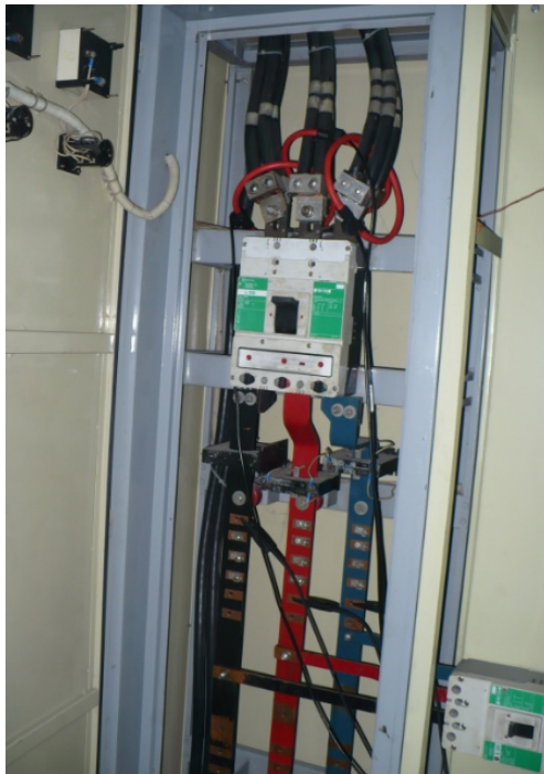
Fuente: Los Autores, Ilustración 27, Instalación del Analizador Fluke 435 dentro del tablero TDP2, 2010.
