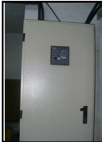
Fuente: Los Autores, Ilustración 19, Tablero de Transferencia, 2010.
