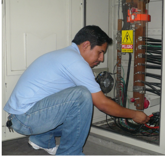
Fuente: Los Autores, Ilustración 24, Instalación del Analizador Fluke 435 dentro del tablero TDP1, 2010.
