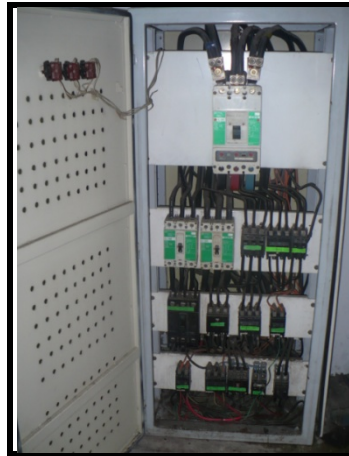
Fuente: Los Autores, Ilustración 30, Tablero TDP3 con sus Breakers, 2010.
