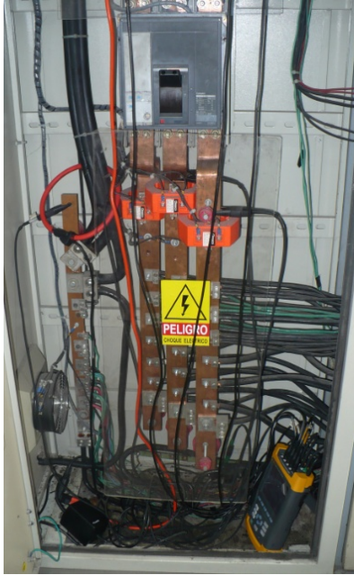
Fuente: Los Autores, Ilustración 24, Instalación del Analizador Fluke 435 dentro del tablero TDP1, 2010.
