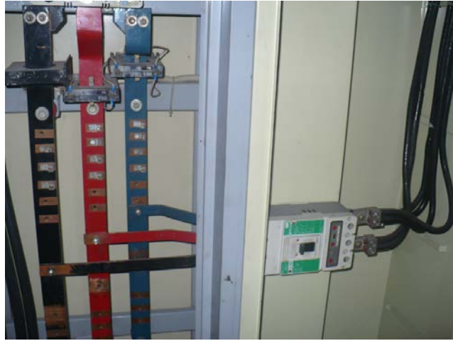
Fuente: Los Autores, Ilustración 26, Juego de barras del tablero TDP2, 2010.
