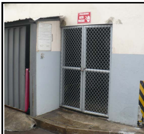
Fuente: Los Autores, Ilustración 15, Cuarto de Transformación, 2010.
