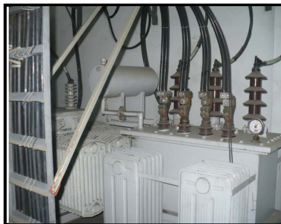
Fuente: Los Autores, Ilustración 18, Transformadores Trifásicos, 2010.
