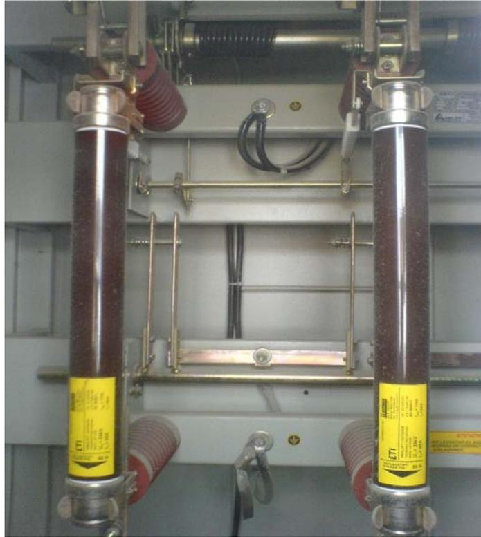
Foto 3.4. Fusible de seccionador tipo AT 630-20F
