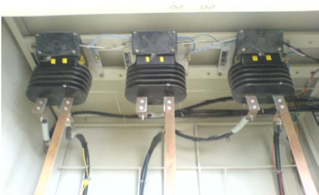
Foto 3.3. Transformador de corriente
