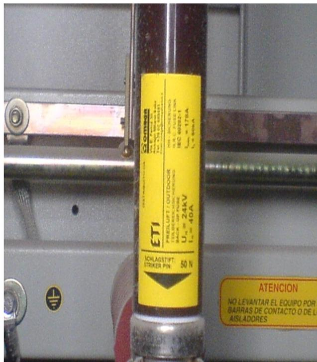
Foto 3.5. Fusible de seccionador tipo AT 630-20F marca ETI
