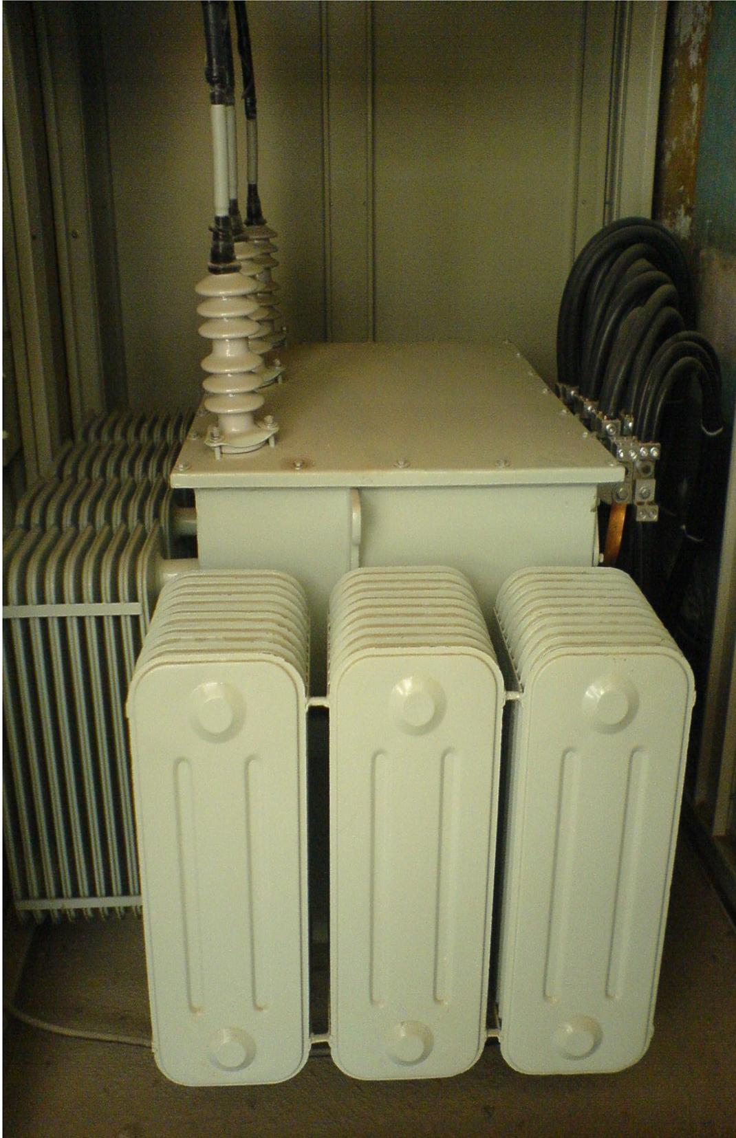
Foto 3.7. Transformador trifásico de 500KVA
