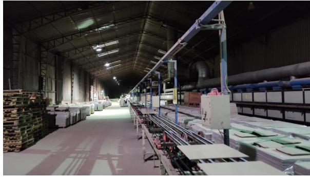
Figura 2.9: Iluminación de la nave industrial 3.
