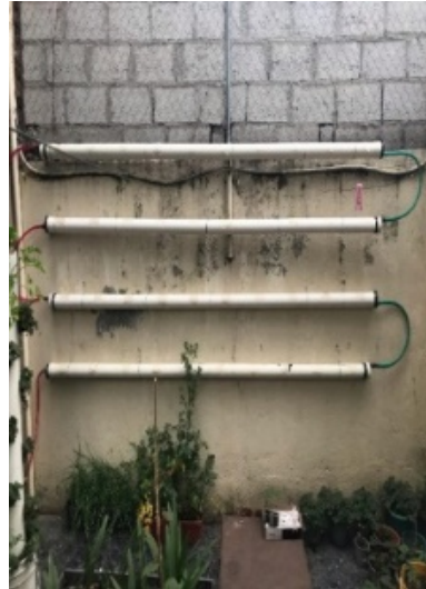
Figura 1. Instalación del sistema Fuente: Autor
