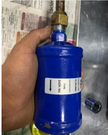
Figura 2. 22 Dirección de flujo de filtro secador
