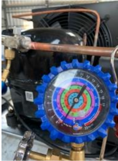
Figura 2. 26 Vaciado del sistema y comprobación de fugas
