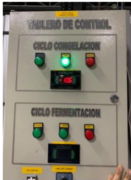
Figura 2. 35 Circuito de mando para las etapas de congelación y fermentación
