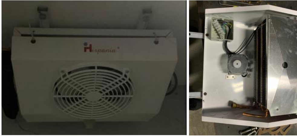
Figura 2. 24 Evaporador vista interna y externa
