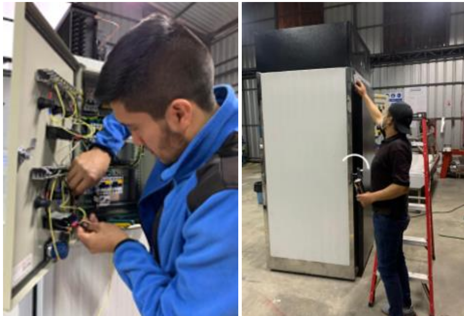
Figura 2. 34 Ensamble del circuito de mando para las etapas de congelación y fermentación.
