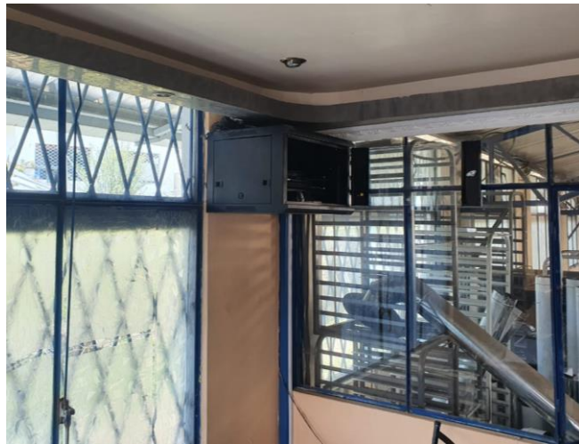
Figura 2.7 Instalación del rack de servicio en el departamento de hornos
