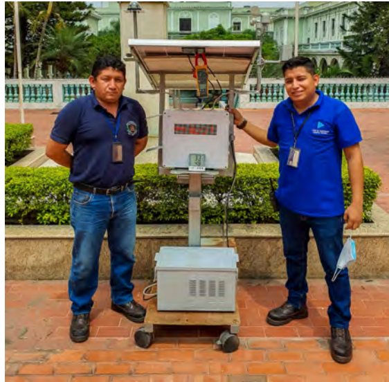
Figura 5.13: Instalación del sistema de monitorización externo.
