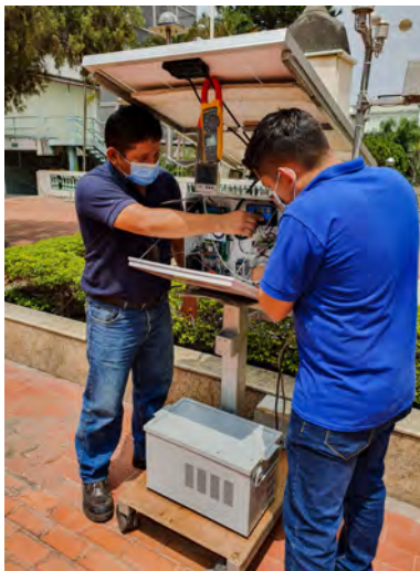
Figura B.10: Instalación y verificación del sistema externo de monitoreo.
