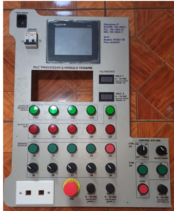
Figura 47. Montaje de Elementos en el plafón superior
