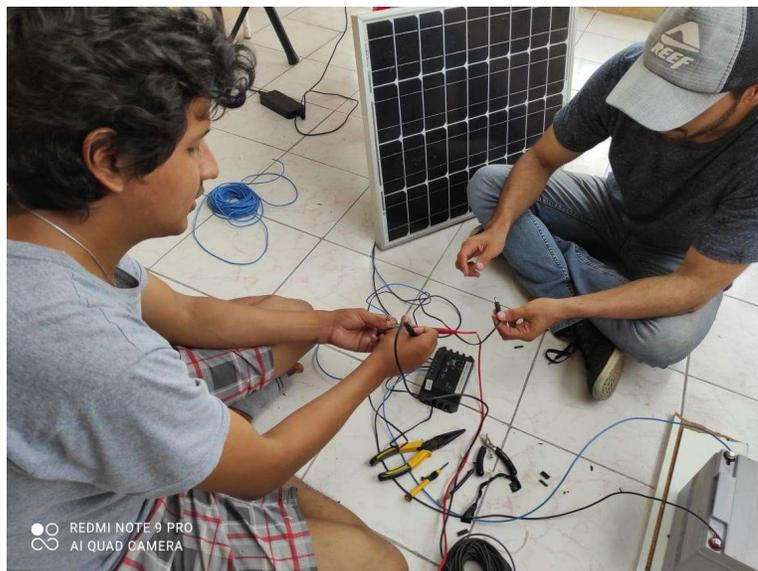
Figura 3.25 Cableado del sistema solar
