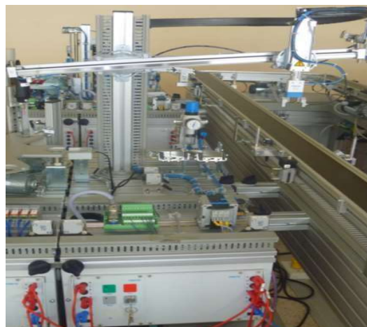
Figura 5. Estación de manipulación [13]
