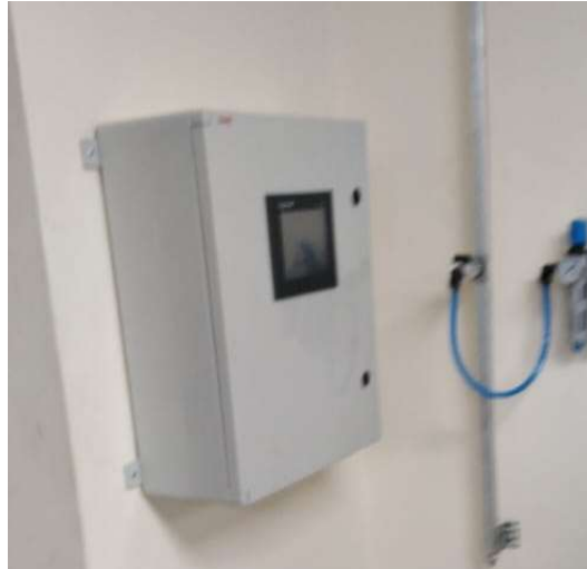
Figura 30. Montaje en sitio del tablero OEE [13]
