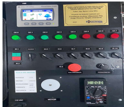
Figura 47. Instalación del panel de control
