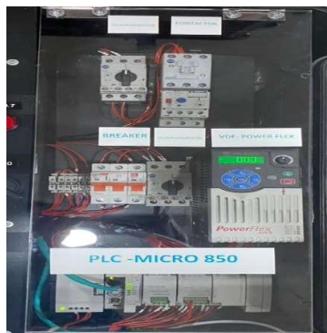
Figura 46. Instalacion de automatización
