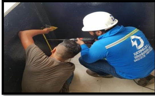
Figura 88: Medición y montaje de canaletas para el cableado eléctrico civil, fuente: Los Autores.
