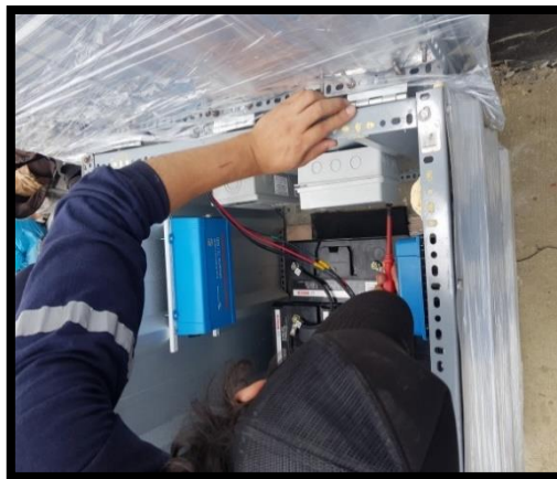
Figura 84: Montaje del Breaker Principal y Baterías, fuente: Los Autores.
