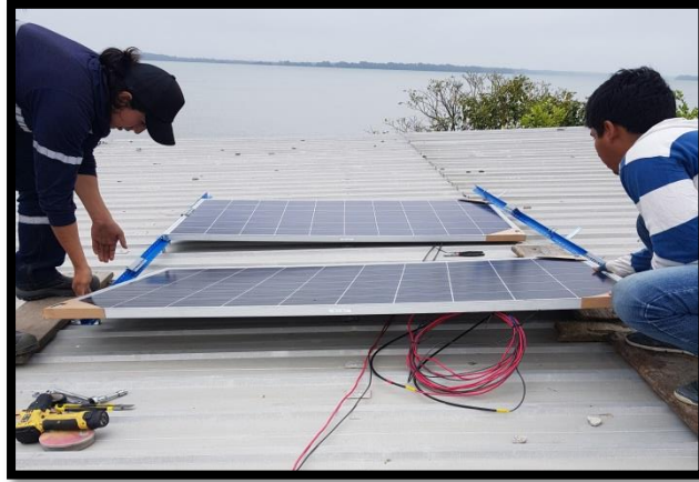
Figura 80: Adecuación para la Orientación e Inclinación, fuente: Los Autores.
