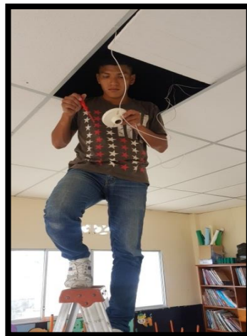
Figura 89: Cortes de tuberías y canaletas para el cableado eléctrico civil, fuente: Los Autores.
