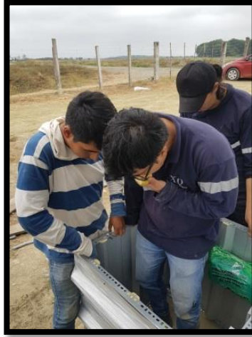
Figura 83: Ajuste de las canaletas, tomas e interruptores, fuente: Los Autores.
