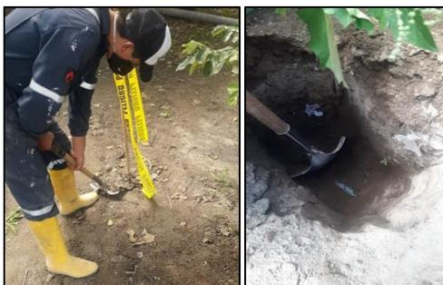
**Nota:** Excavación de pozos para identificación de profundidades de tuberías. Elaborado por:
