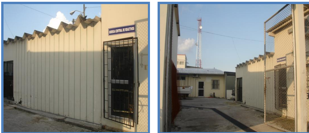
Imagen16 y17: Bodega para Residuos Químicos por habilitar
