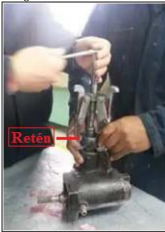
Figura 39. Extracción del retén.
