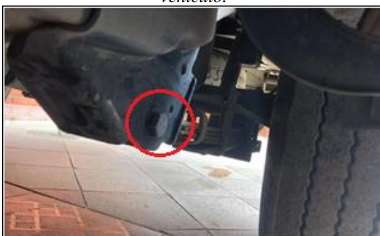
Figura 30: Fijación del soporte con la carrocería del vehículo.
