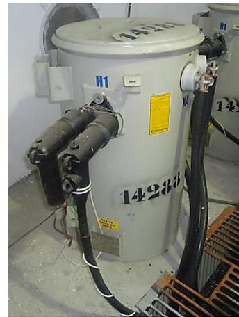
Fig. 3. Transformador convencional con frente muerto, operan específicamente en cámaras a nivel, se ubica en el primer nivel alto, planta baja (PB) o el subsuelo [5].
