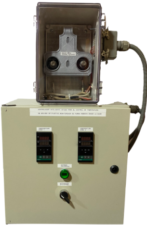
Figura 4.17: Tablero eléctrico de control vista externa
