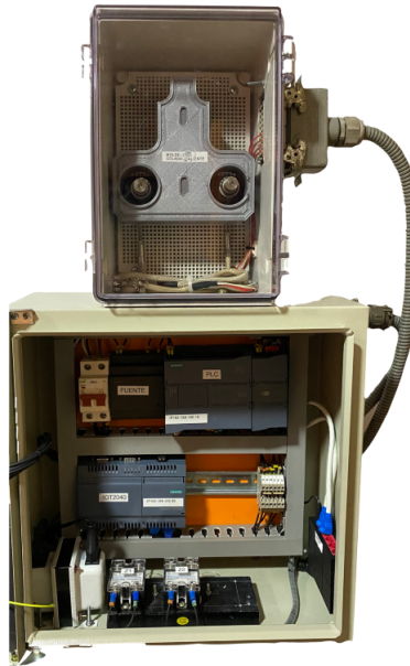
Figura 4.16: Tablero eléctrico de control vista interior
