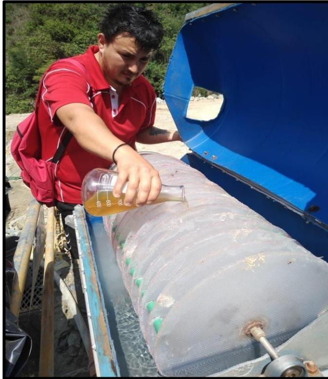
**Figura 19.** Aplicación de inóculos al sistema de biodiscos
