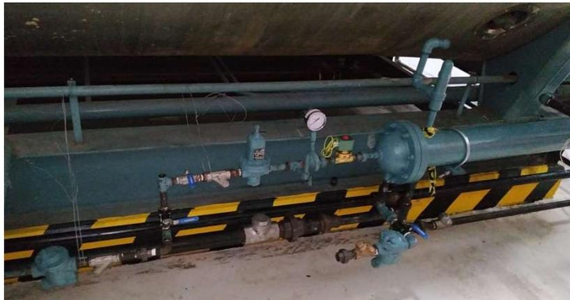
**Figura 25.** Modelo Real de Línea de Vapor para un Intercambiador
