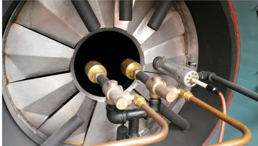
*Figura 12. Registro y Cañón Atomizador, Caldera Colmaquinas
