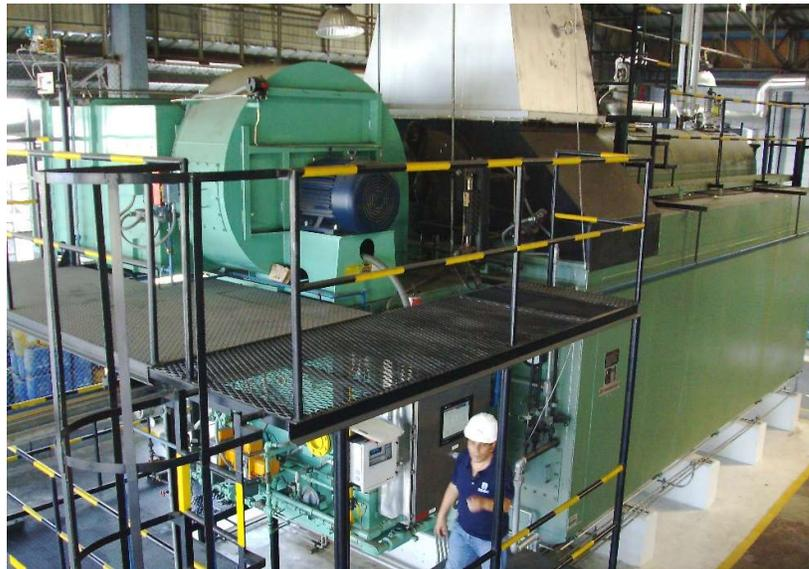
**Figura 3.** Caldera Acuotubular de Bunker, Marca Faber Burner
