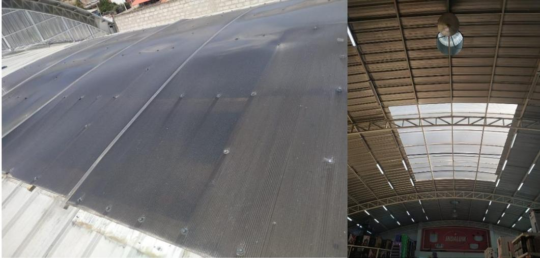
Figura 2-21 Lámina de policarbonato de la 1ra Planta Alta.
