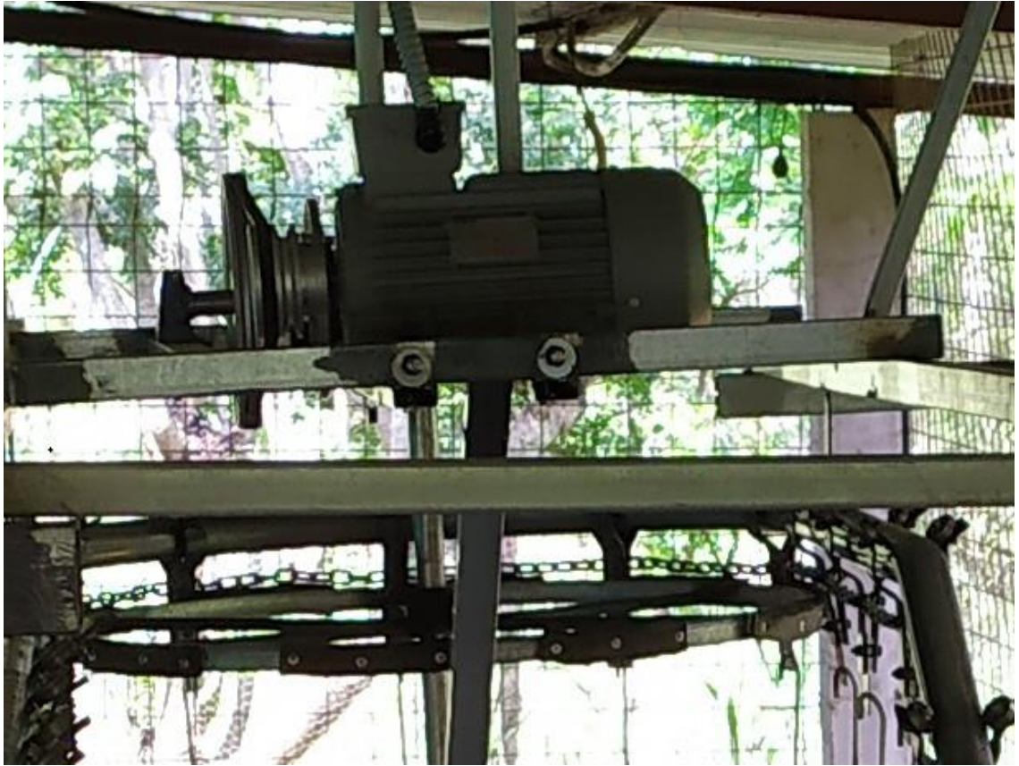
Figura 28: Motor de banda transportadora aérea. Fuente: (Autores)
