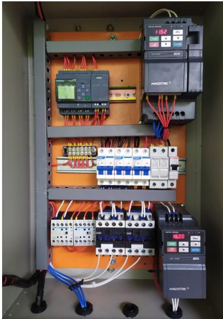
Figura 26: Panel de control sección interior. Fuente: (Autores)
