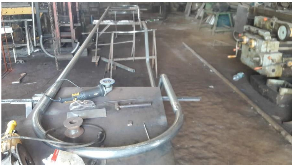
Figura 11: Construcción del monorriel.
