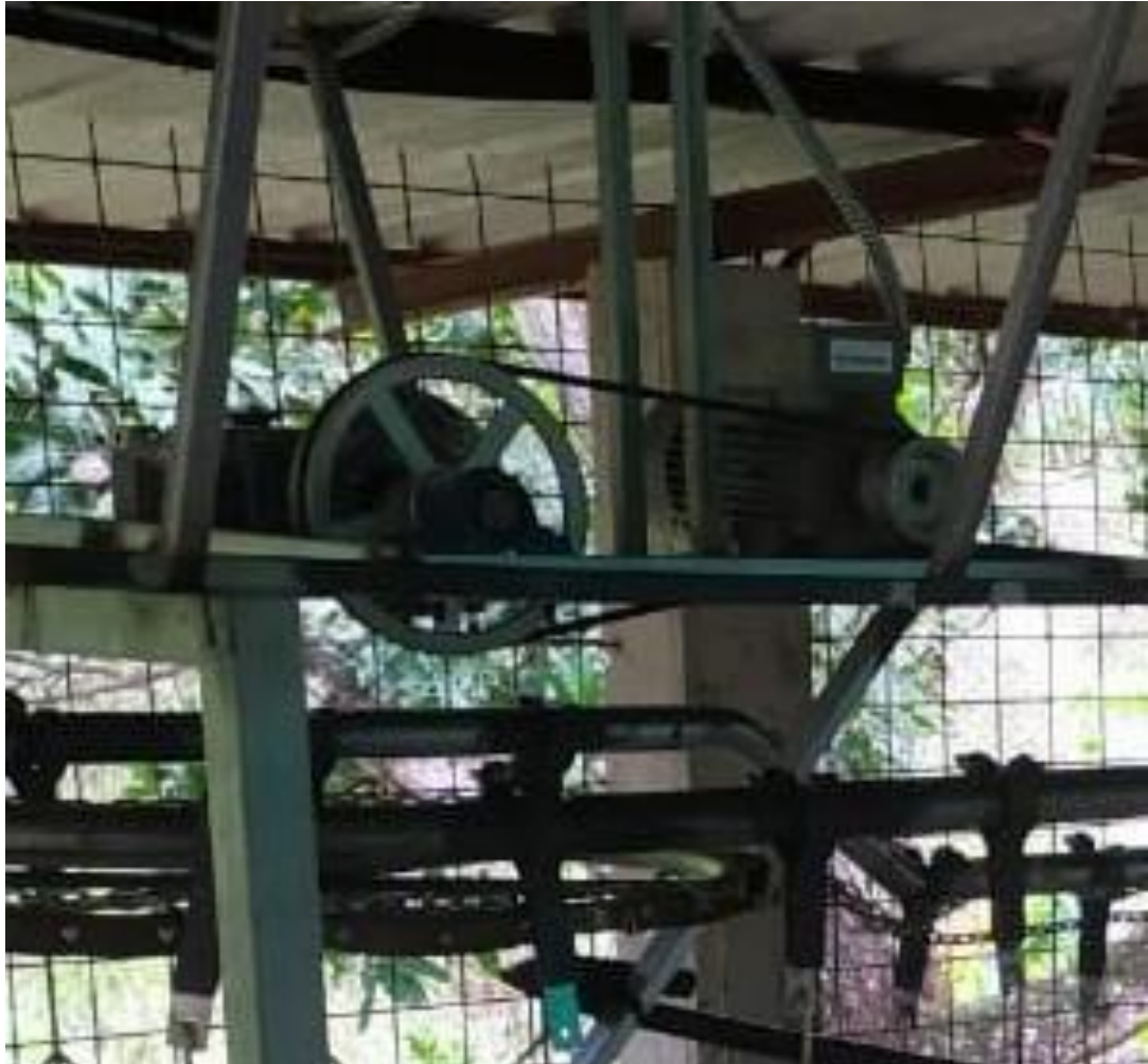
Figura 31: Vista superior del sistema de arrastre y sistema de reducción. Fuente: (Autores)
