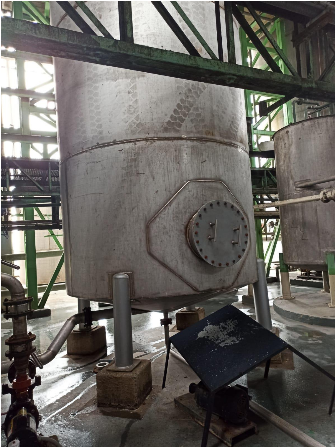
ANEXO 14 Columna recuperadora Instalada
