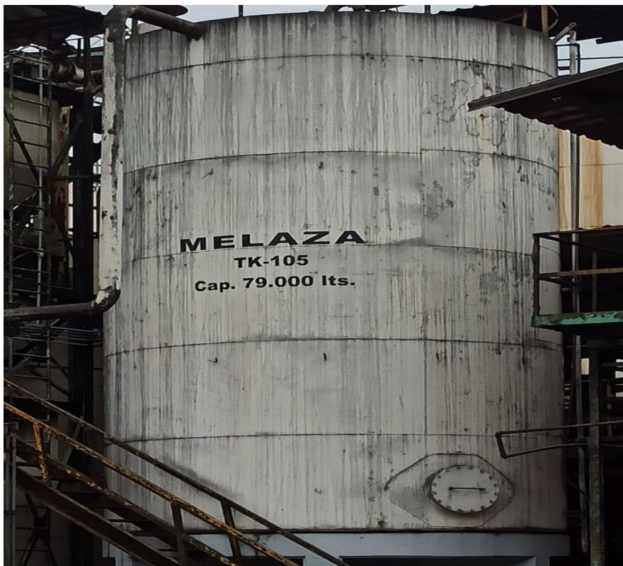
ANEXO 2 Tanque de melaza con capacidad instalada de 79000Lt
