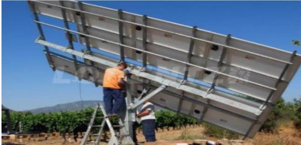
**Figura 18.** Instalación de un seguidor solar
